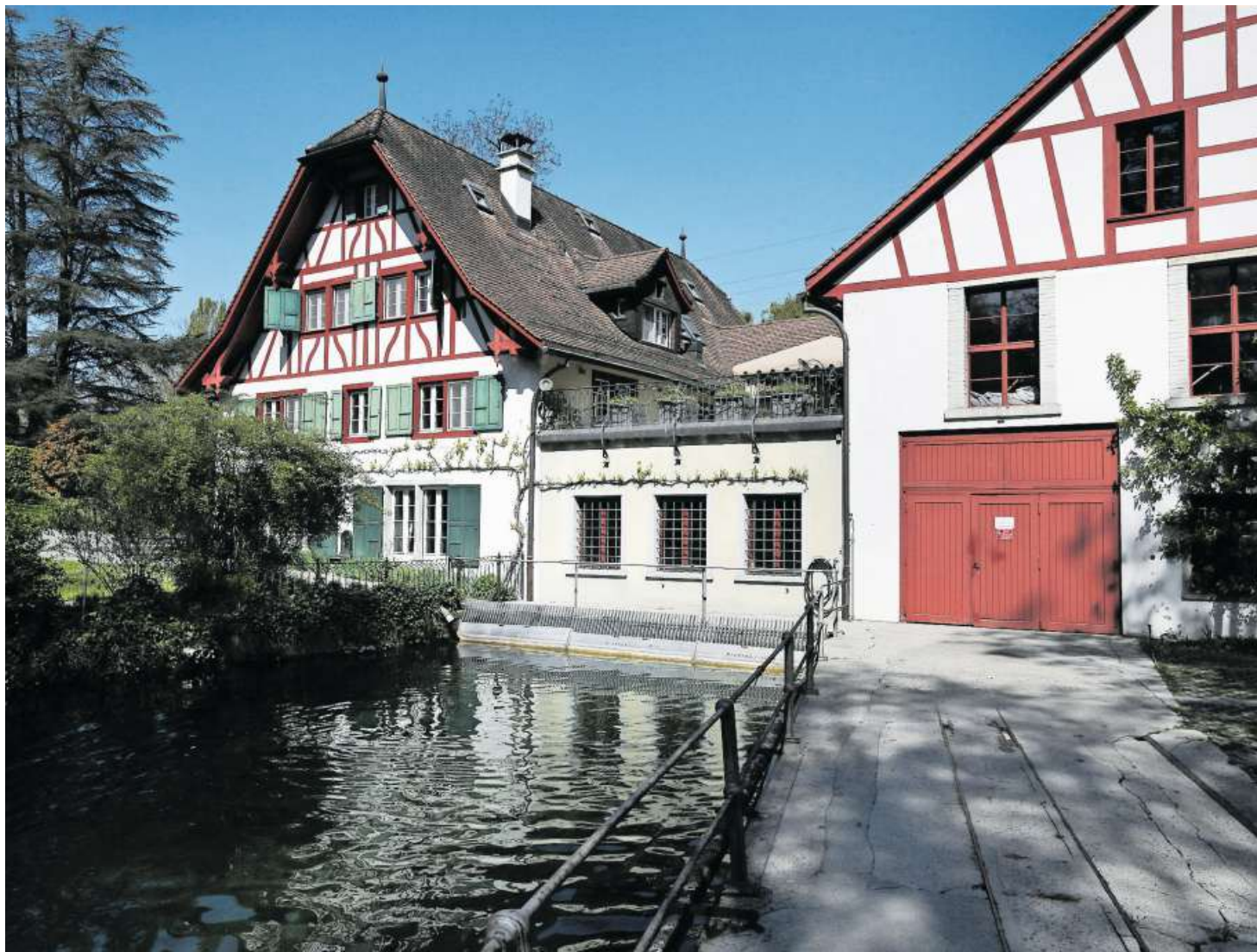
Das Kleinwasserkraftwerk Hammer in Cham.
