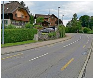
Der Deckbelag in der Adligenswiler Strasse muss erneuert werden. z.Vg.
