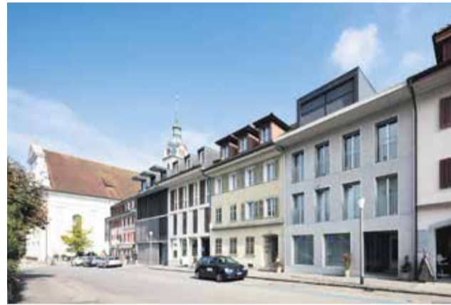
Ein Neubau anstelle einer Baulücke und zwei Ersatzneubauten ergänzen die Häuserzeile an der Oberstadtstrasse in zeitgemässer Architektursprache. Foto Gaetan Bally/Keystone
